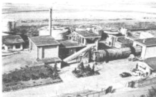
吉津清掃工場 (50t/日し尿処理施設, 50t/日コンポスト施設)
